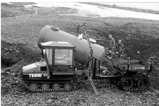
Figura 3. Instalación de una fosa séptica prefabricada.
