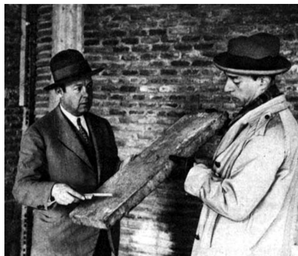
El maestro de obras Sr. Gutiérrez Criado, muestra á nuestro compañero Juan del Sarto un trozo del conglomerador de corcho que se emplea, como elemento aislador, en la construcción de los laboratorios del Instituto.
